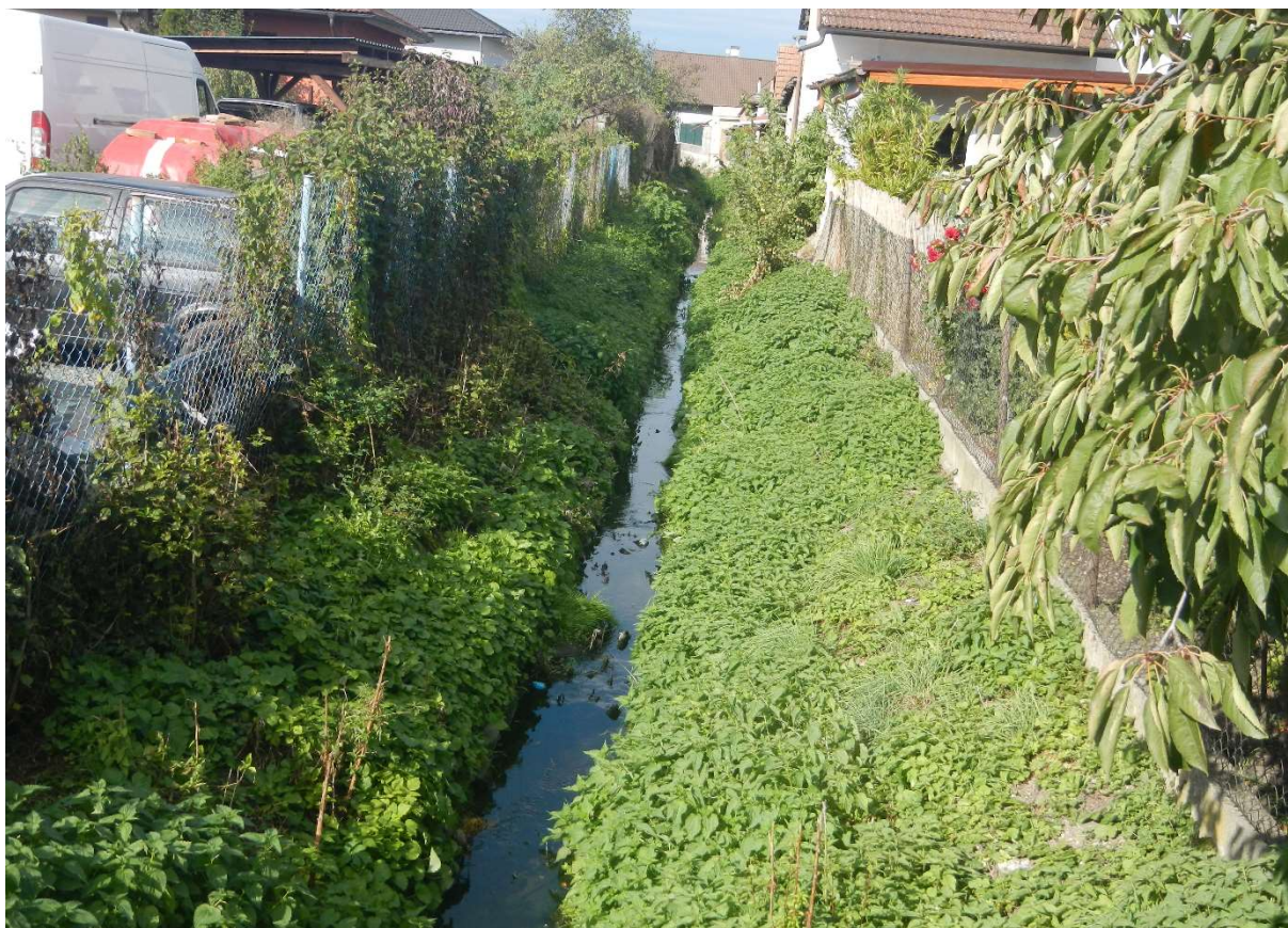
Obr. 13: Koryto v ř.km 7,50-7,57, navržená rekonstrukce opevnění koryta, prostorově stísněný úsek, pohled po toku (X/2019)
