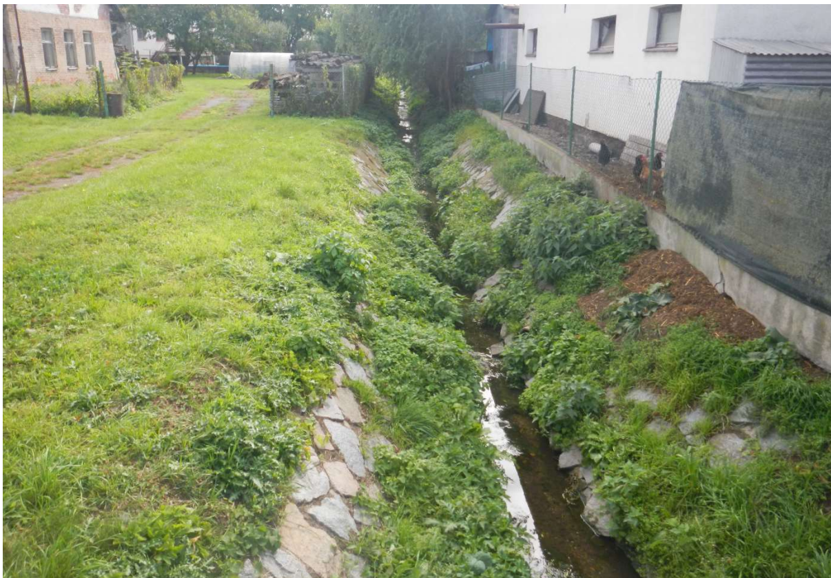
Obr. 7: Koryto v ř.km 6,320, navržená rekonstrukce opevnění dna, rozšíření o PB bermu, přezdění paty a celoplošné přespárování LB opevnění (X/2019)
