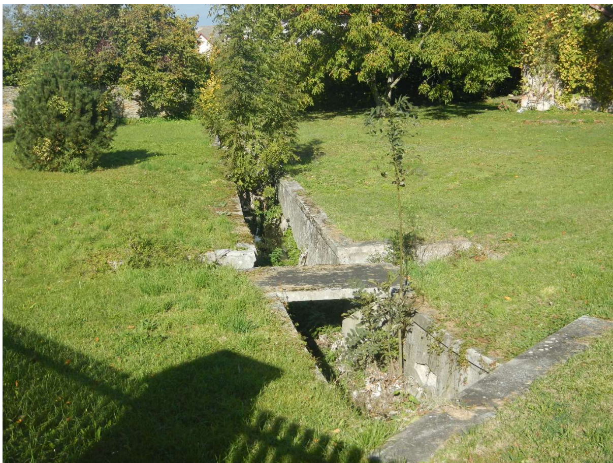
Obr. 15: Koryto v ř.km 7,70, úsek havarijních svislých zdí v zahradě evangelické fary (X/2019)
