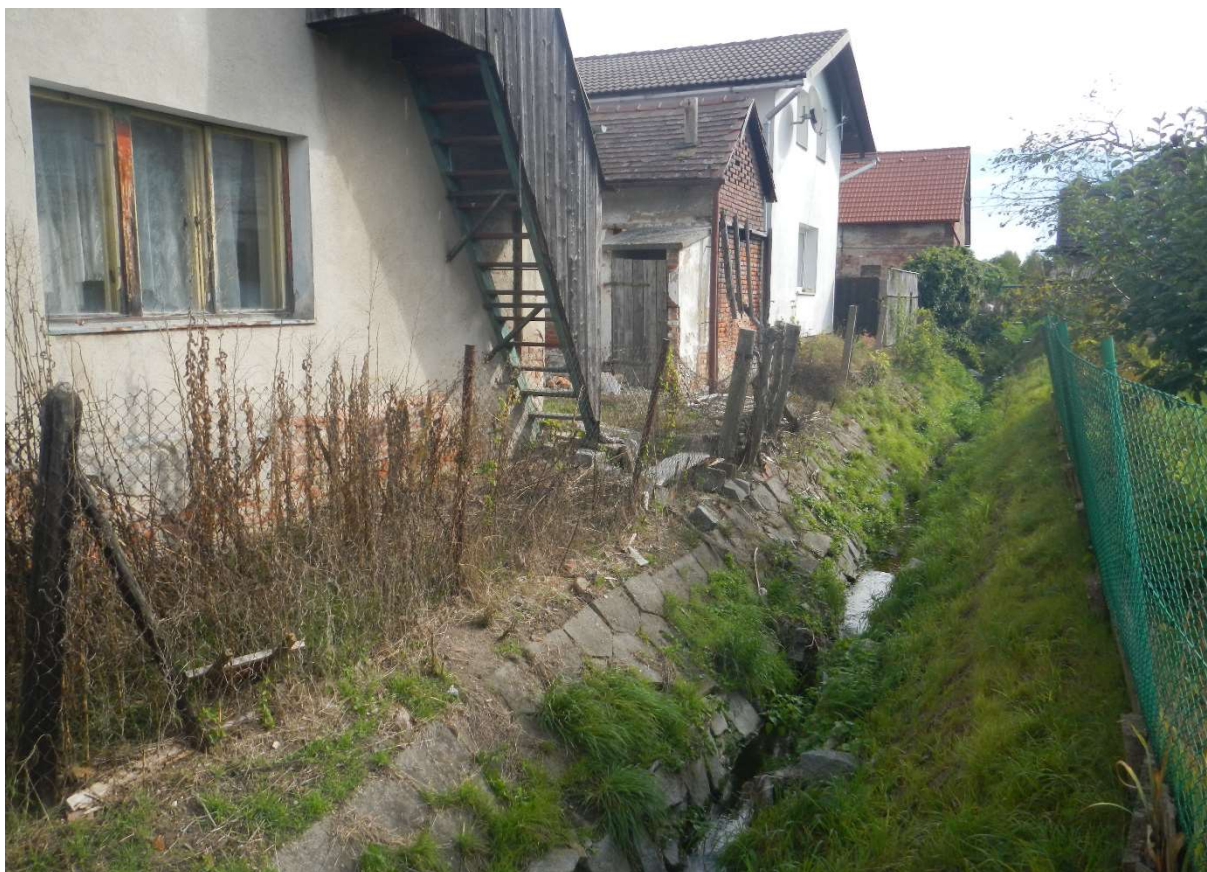
Obr. 11: Koryto v ř.km 7,200, navržená rekonstrukce opevnění koryta, prostorově stísněný úsek, usmyklé podezdívky stáv. oplocení – pohled proti toku (X/2019)
