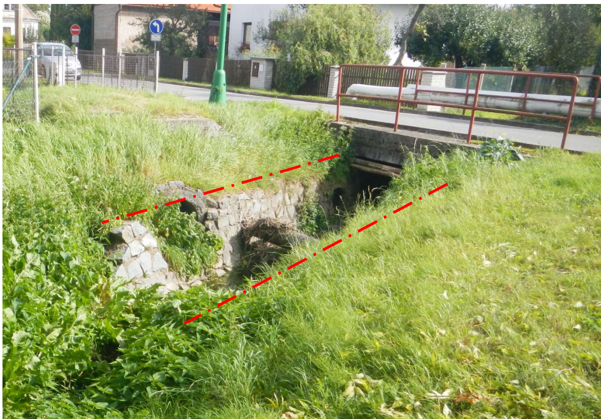
Obr. 3: Břehové opevnění ř.km 6,124 -6,131 (svislé zdi z LK, řádkové zdivo), navrženo celopl. očištění, přespárování a dozdění (tj. zarovnání) horního řádku z LK (X/2019)
