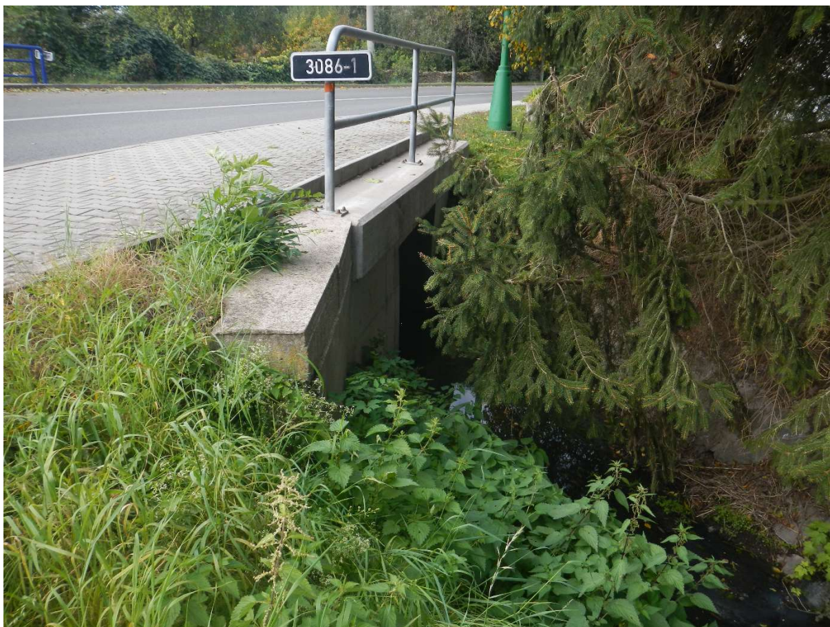
Obr. 1: Začátek rekonstrukce koryta Černilovského potoka – ř.km 6,050, nátokové čelo propustku (X/2019)
