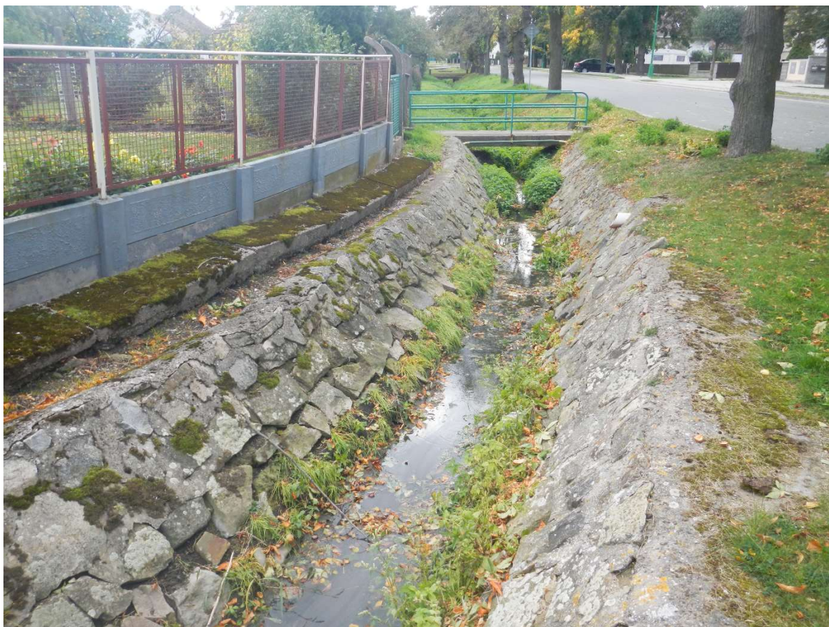
Obr. 9: Koryto v ř.km 6,650-6,750, navržená rekonstrukce opevnění koryta (X/2019)
