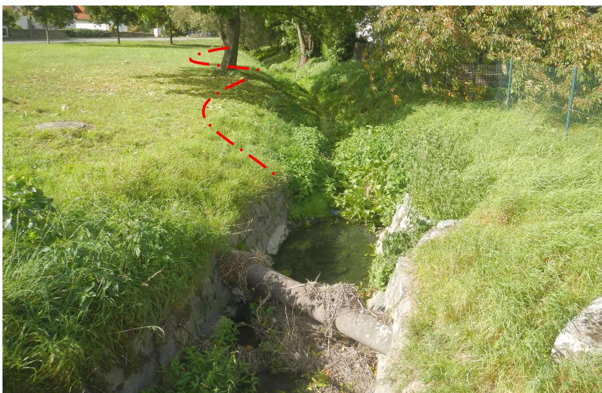
Obr. 4: Koryto v ř.km 6,060-6, 131, břehové opevnění a kanalizační řád (KhP a.s.) v průtočném profilu. Červeně naznačeno navržené částečné rozšíření břehů koryta, vzdálenější – sedimentační zdrž (X/2019)
